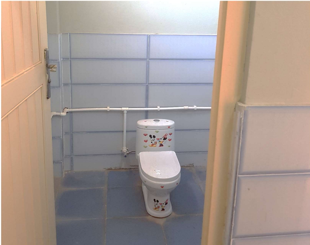
Baño del preescolar construido en la escuela Zaid Ibn Tabit
