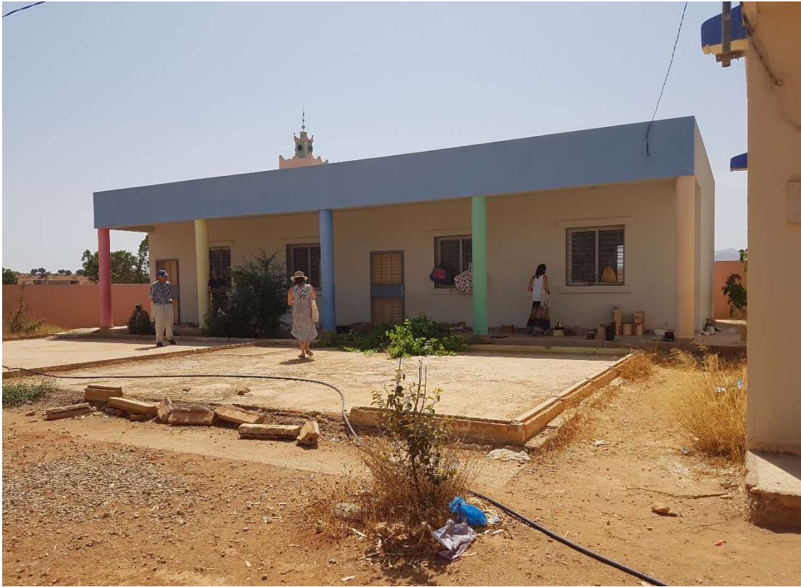
Las dos aulas construidas en la escuela Ahl el Oued
