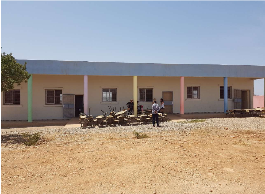
Las tres aulas construidas en la escuela Mebrouka
