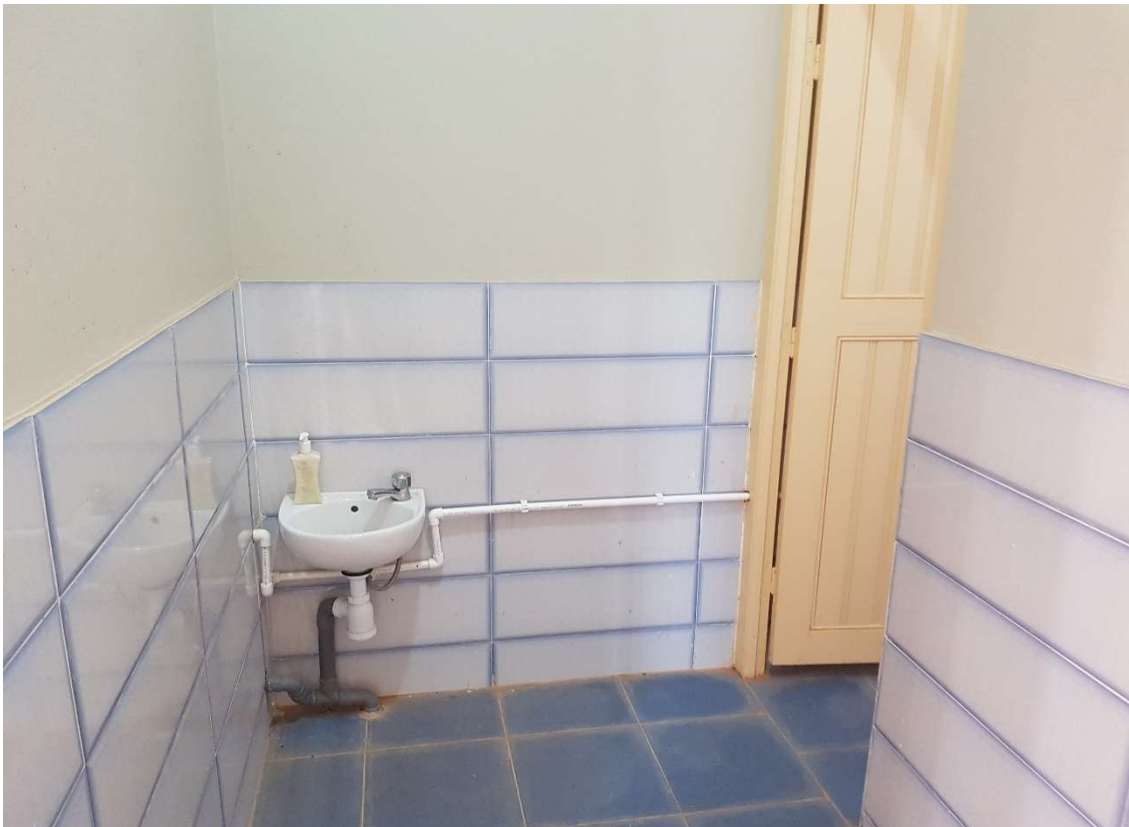
Baño del preescolar construido en la escuela Zaid Ibn Tabit
