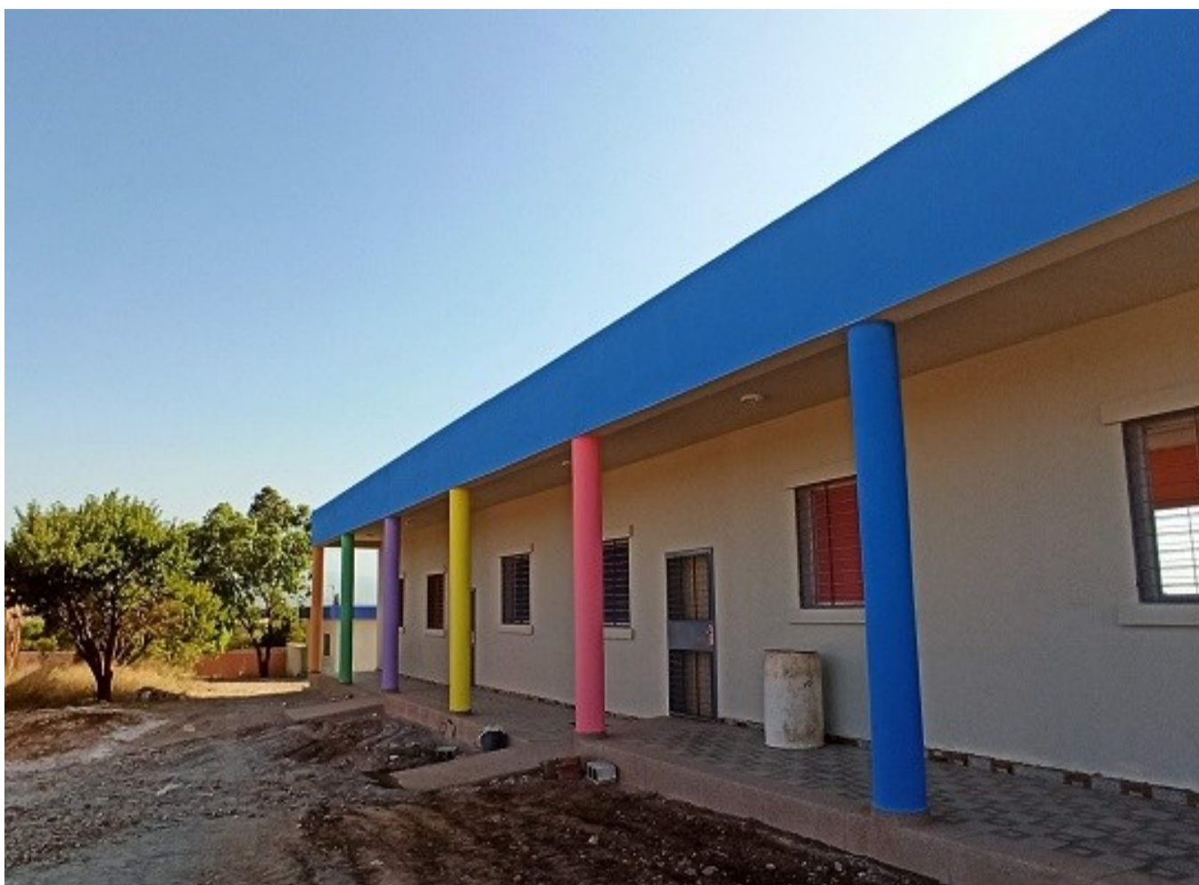
Nuevas aulas accesibles a personas con movilidad reducida, construidas en la escuela satélite Mabrouka, perteneciente al grupo escolar Zaid Ibn Tabit en la comuna de Bourghriba.
