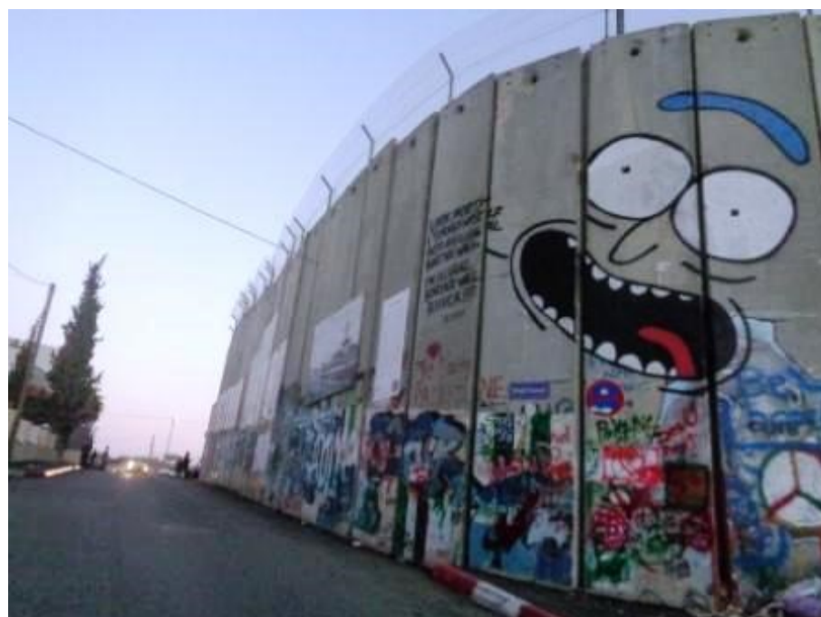
El muro de separación en Belén // Fotografía: Miguel Ángel Troncho
